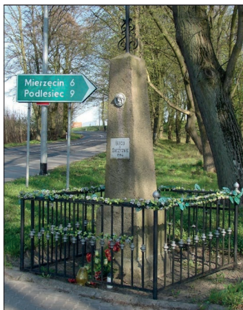
Ein Meilenstein aus der Zeit um 1825, umgebaut zu einer Pfeilerkapelle, gelegen in Dobiegniew
